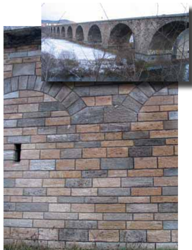
Autobahnbrücke über das Saaletal in Jena aus Terebratelkalk und süddeutschem Muschelkalk (Fotos: Schulze).
