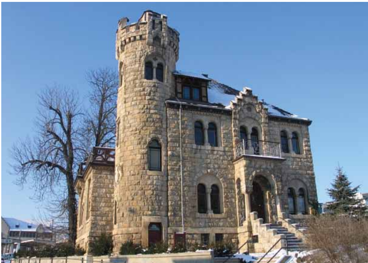
Verbindungshaus des „Corps Saxonia“ in Jena (Foto: Schulze).
